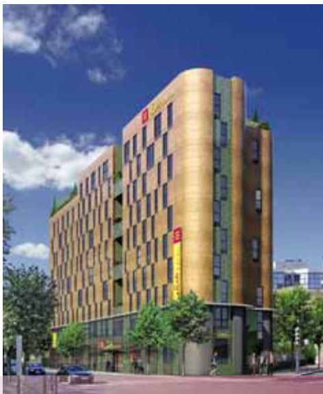
> Suitehotel, HQE® certified hotel, Issy-les-Moulineaux.
