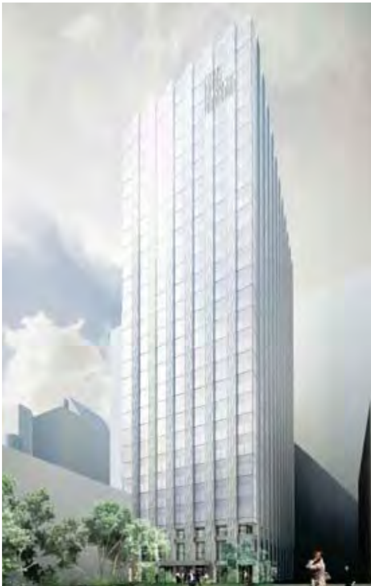
CHARTIS Renovation of the Chartis tower in La Défense – Courbevoie (Greater Paris).
