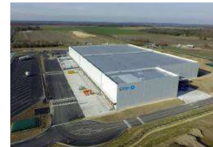
DARVAULT (77) – Fonds FLF1 Plateforme 70 000 m 2 En développement
