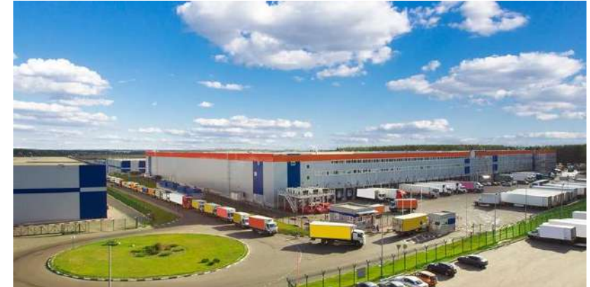
PROJET BOLLÈNE – Investissement direct Parc logistique de 260 000 m 2 sur l'A7 au Nord d'Avignon
