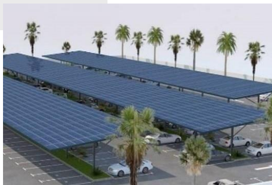
Ombrières de Parking
