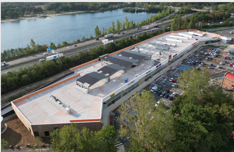
Grandes toitures (ici La Vigie)
