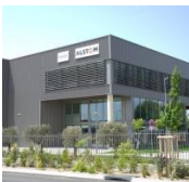
Siège régional d'Alstom Aix-en-Provence (13) Cogedim
