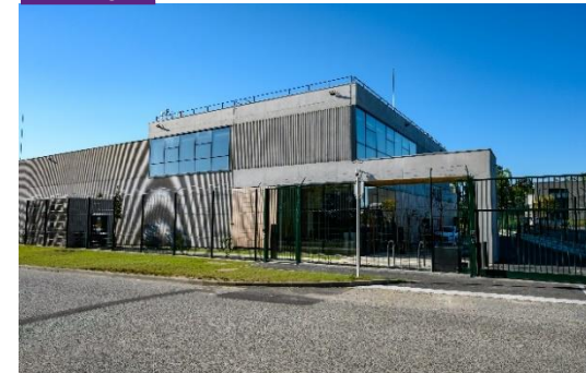
Mise en exploitation du data center NDC Rennes
