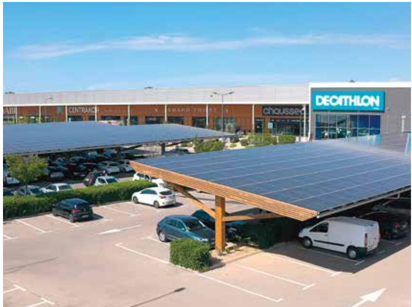
Family Village Costières Sud, Nîmes (30), Altarea Commerce. Architecte : Christophe Vergnaud Architecture et Associés. Ombrières photovoltaïques sur parking installées par Altarea Energies Renouvelables.
