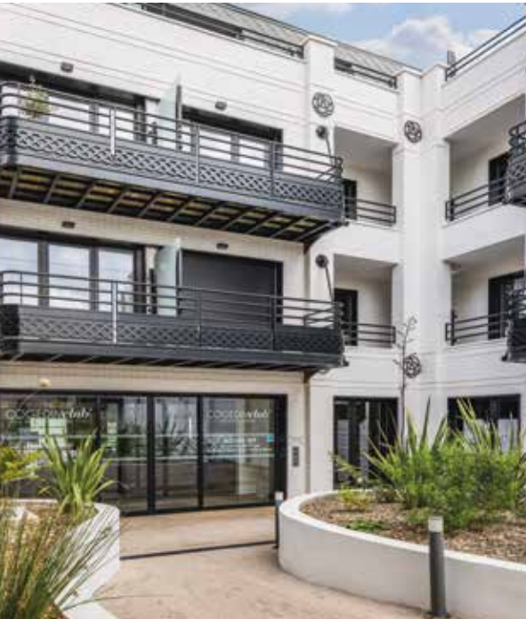
Villa Gabrielle, Asnières-sur-Seine (92), Nohée ; résidence services seniors. Architecte : Archibuild. Livraison : 2022.
