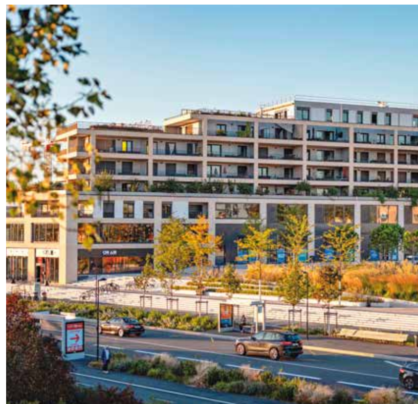
Belvédère, Bordeaux (33), Cogedim, Altarea Commerce; nouveau quartier urbain (logements, bureaux, commerces, résidence étudiants, espaces culturels). Architectes-urbanistes : Güller & Güller et GrossMax. Livraison : 2024.
