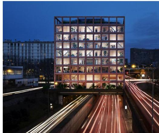
Afin de garantir un haut niveau de confort pour les habitants, l'enveloppe du bâtiment a été équipée d'une façade à double peau vitrée sur l'ensemble de ses orientations. Ce dispositif assure une barrière thermique et acoustique efficace, limitant de manière significative les nuisances. Ainsi, Hosta atteint pour chacun de ses logements un DPE A et a reçu les labels BBCA, Effinergie+ et NF Habitat.
