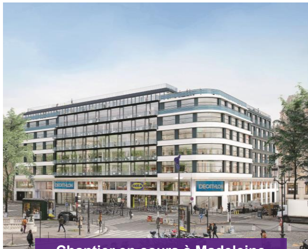
Chantier en cours à Madeleine
